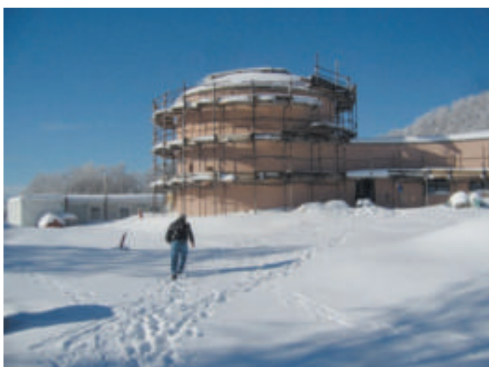
novembre, l'Osservatorio Astronomico in costruzione
