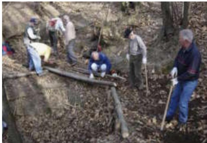
Lavori di manutenzione al sentiero Camarza – Reopasso
