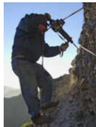
Lavori sulla ferrata del Reopasso
