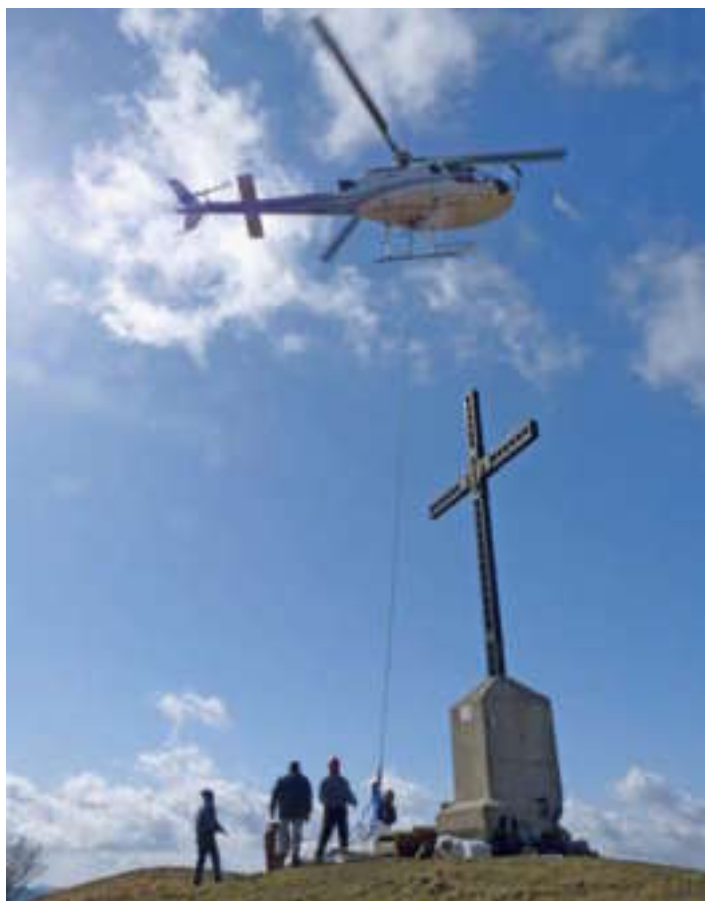
Trasporto materiali per il restauro della croce sul Monte Buio
