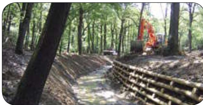
Foto sopra: realizzazione di palificata di sostegno mediante tecniche di ingegneria naturalistica presso le Lanche della Bassa Mandrello per il sostegno dell'argine di separazione tra lanca e rio
