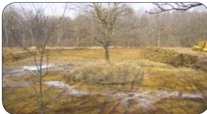
Foto sopra: Lanche Ferloch durante i lavori di rimodellamento ed impermeabilizzazione del fondo e delle sponde
