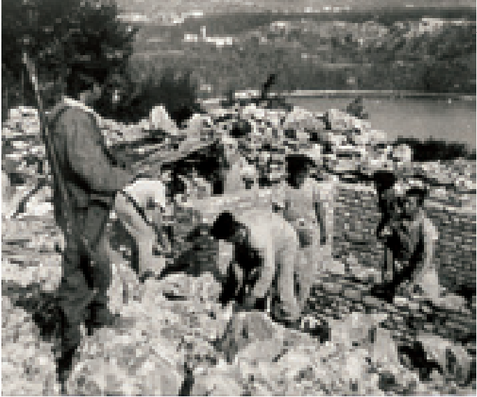
Marinesoldaten beim Bau einer befestigten Beobachtungsstelle auf dem gleichen Punkt des vorhergehenden Bildes.
